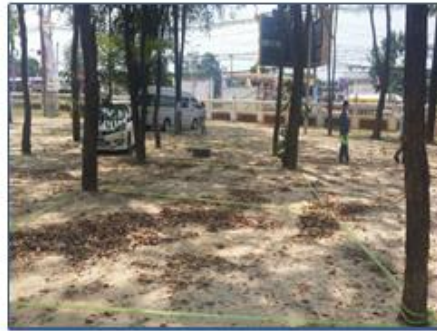
ชื่อสถานที่ ลานจอดรถและถนนภายใน วันที่คาดว่าจะปรับปรุง ๓๐มิ.ย.๖๑ ผู้รับผิดชอบ สมชาย มีธรรม
