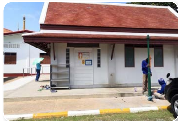
ภาพแสดงสภาพก่อนปรับปรุง หมวดที่ ๔ ห้องน้ำ บันทึกภาพไว้เมื่อวันที่ ๑๗ เดือน มกราคม พ.ศ. ๒๕๖๓ ผู้บันทึกภาพ คือ พระปลัดธนัทธน์ คุณทสสี
